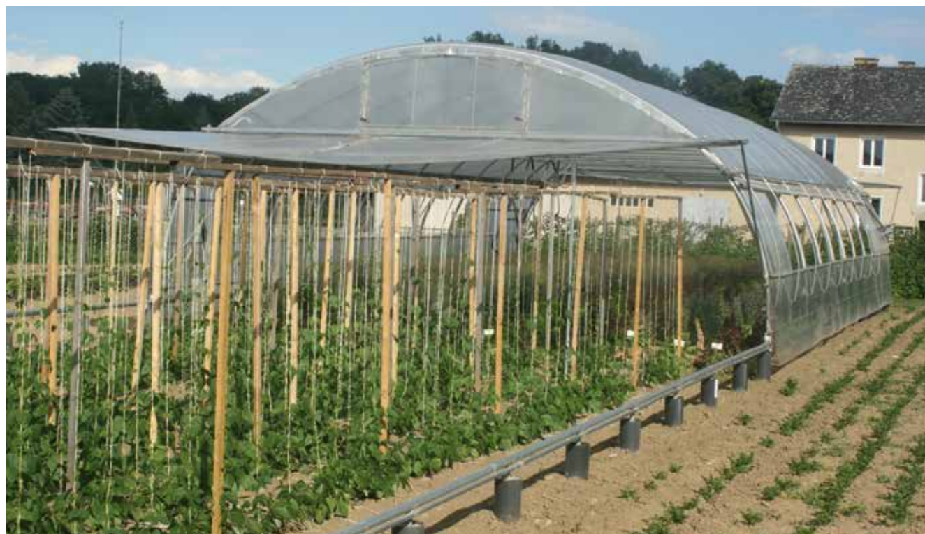
Der Rolltunnel der Gartenbauschule Langenlois läuft auf Schienen. Die Giebelwand kann hochgeklappt werden und sogar hochwachsendes Gemüse überfahren (© Wolfgang Palme, HBLFA Schönbrunn)
